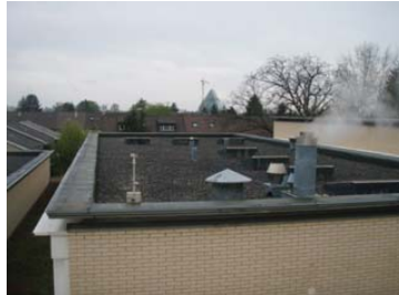
Auf diesen Dachflächen des Schulhauses Donnerbaum wird die Fotovoltaikanlage parallel zum Dachrand angeordnet.
