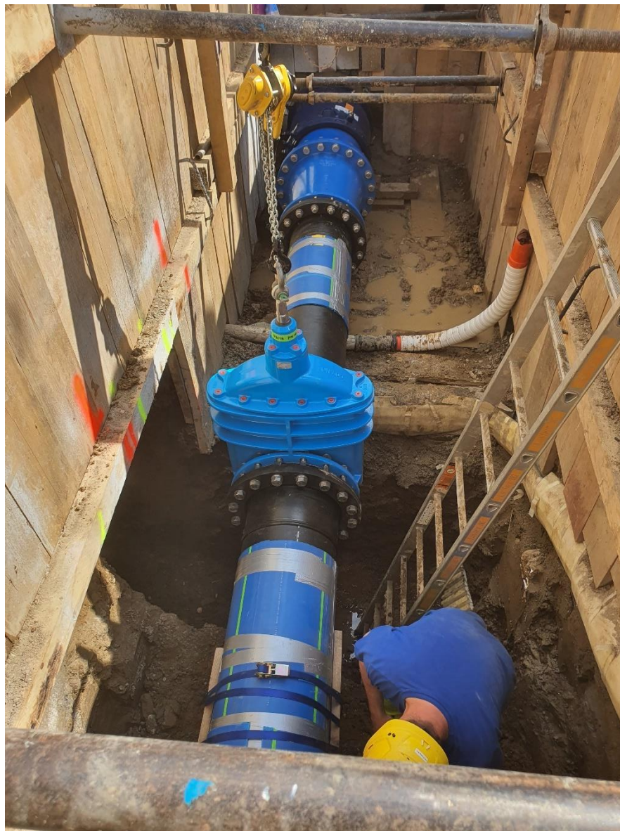
Abb. 13: Leitungsgraben für den Zusammenschluss mit der bestehenden Eternitleitung
