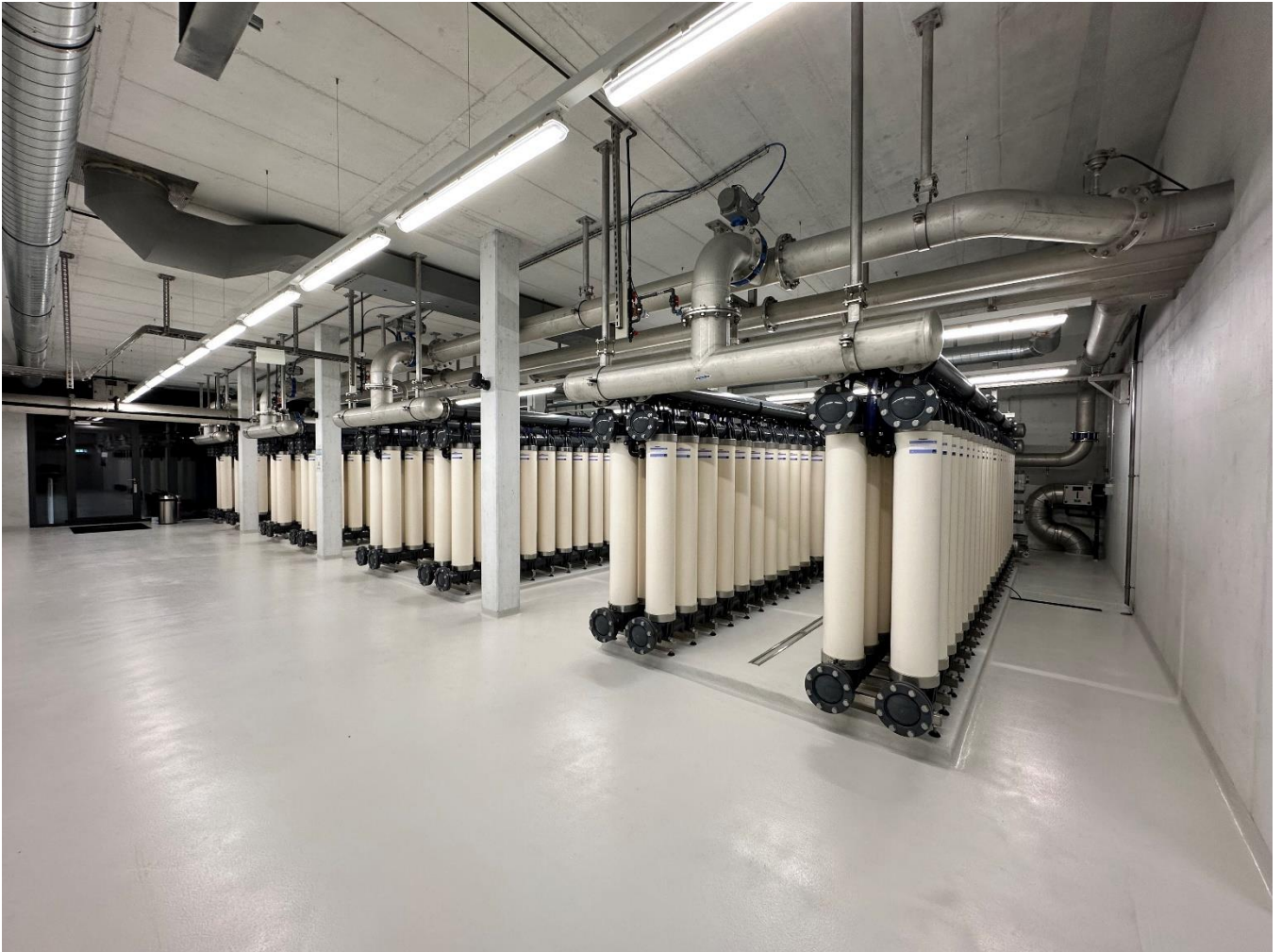
Abb. 9: Die Ultrafiltrations-Stufe der TWA. Hier wird die zuvor zugesetzte Pulver-Aktivkohle wieder abgetrennt
