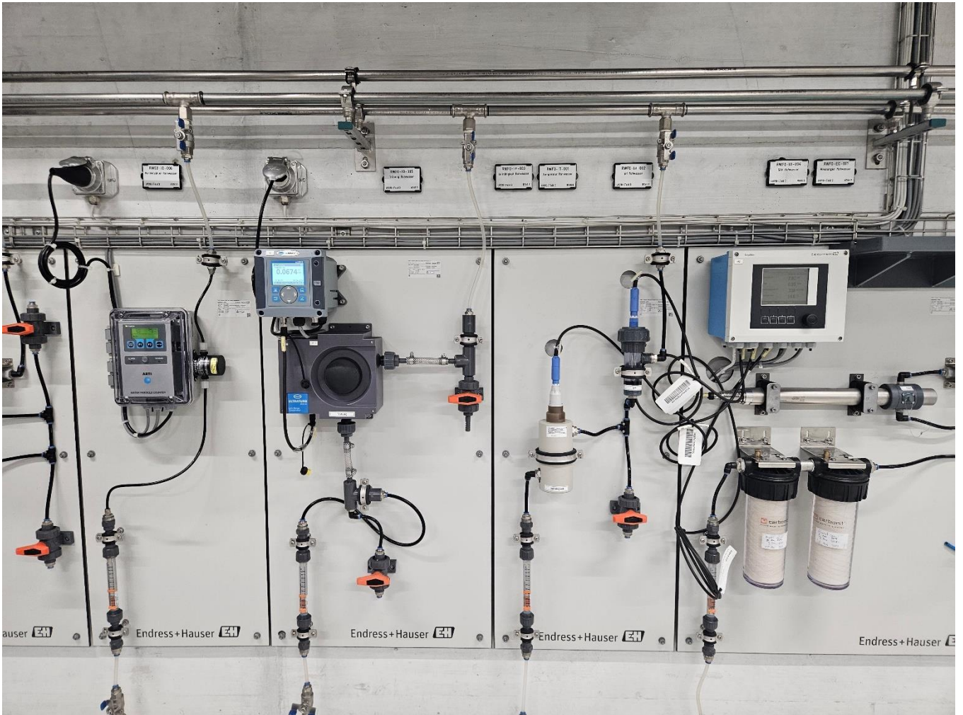
Abb. 7: Die aufwändige Online-Messtechnik in der TWA.
