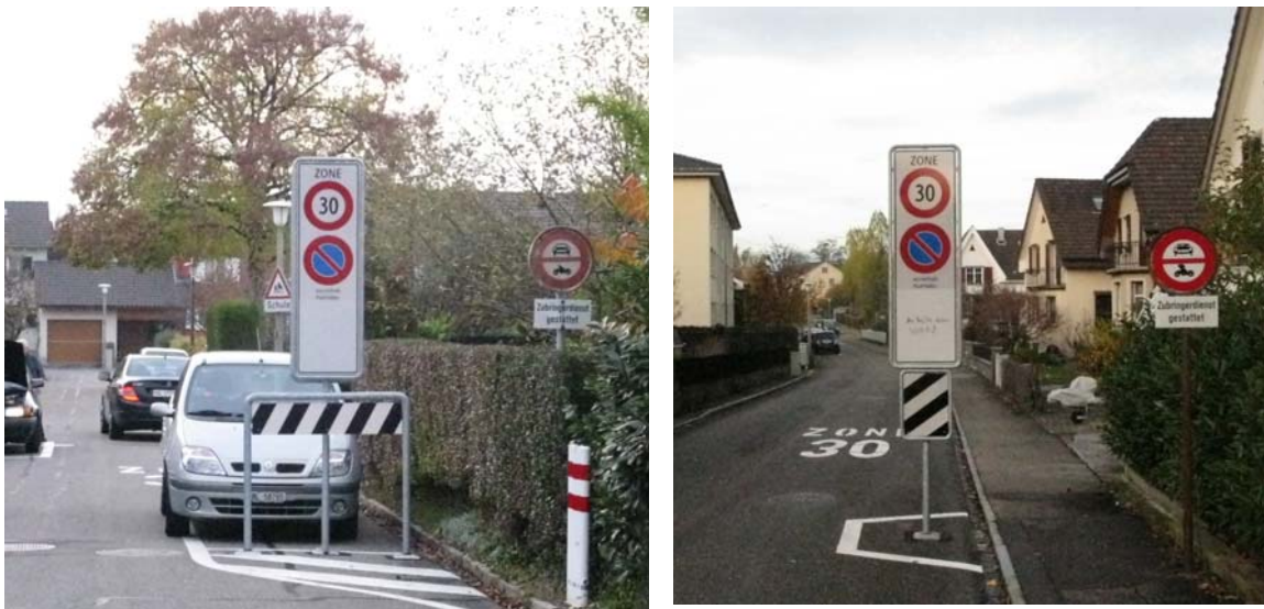
Abbildung 1: Torbildung an der Zonengrenze in der 1. Etappe (Typ „breit“ links, Typ „schmal“ rechts)
