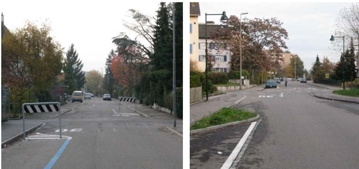
Abbildung 2: Horizontaler Versatz (links) und Markierung Rechtsvortritt (rechts) aus der 1. Etappe
