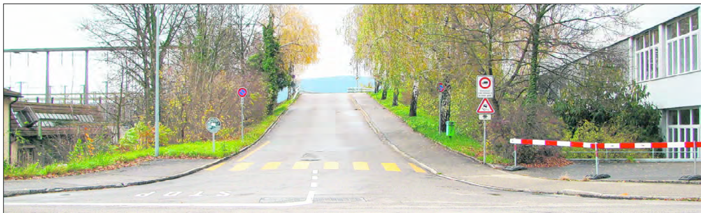
Strassenparzelle 472, die aus dem Verwaltungsvermögen in das Finanzvermögen der Einwohnergemeinde überführt und verkauft werden soll.
