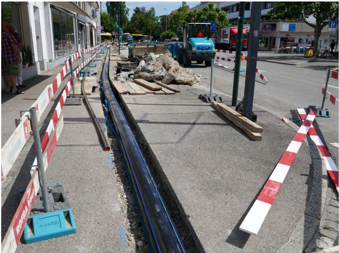
Das Provisorium für die Transportwasserleitung ist erstellt...
