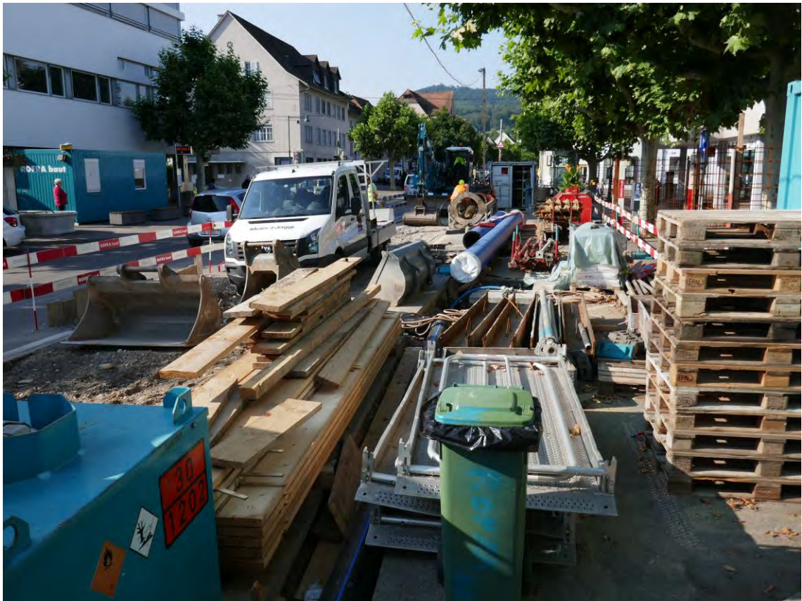
Auf der Baustelle ist es nicht nur für den Verkehr eng
