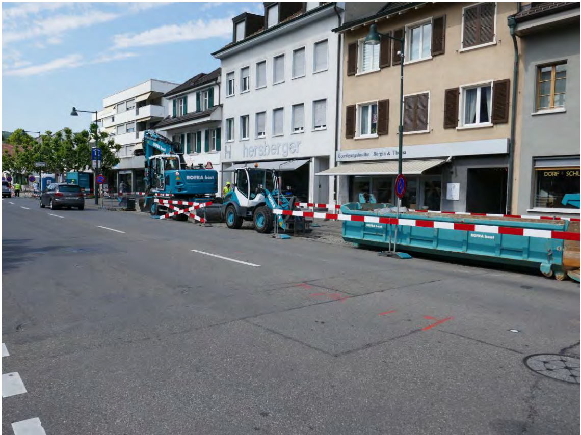
Die Bauarbeiten haben begonnen
