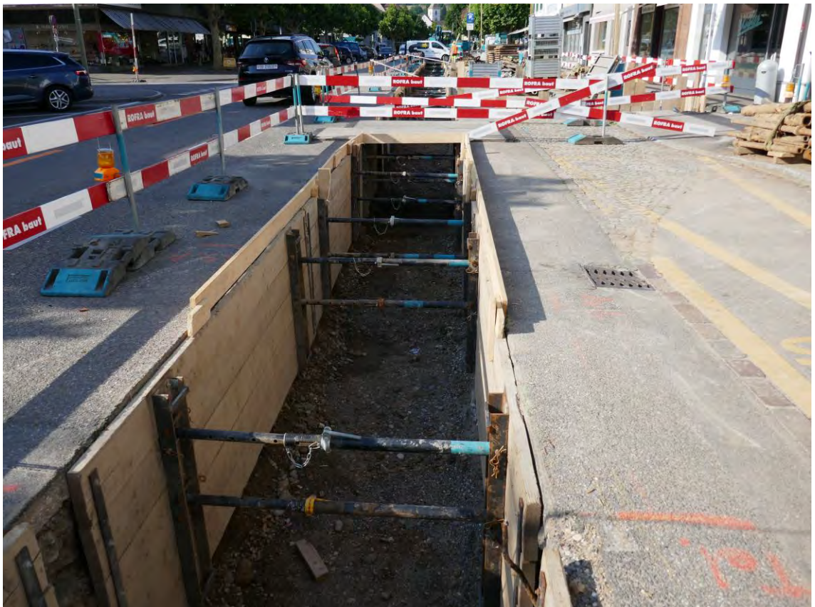
Der Graben für die neue Transportwasserleitung ist schon fast fertig
