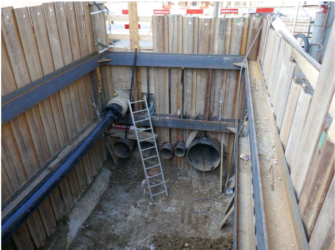
Die Stahlschutzrohre für die verschiedenen Werkleitungen sind unter dem Tram hindurch ...
