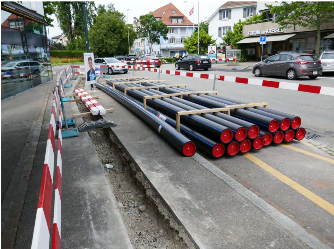
Die Gräben für das Provisorium der Transportwasserleitung sind erstellt
