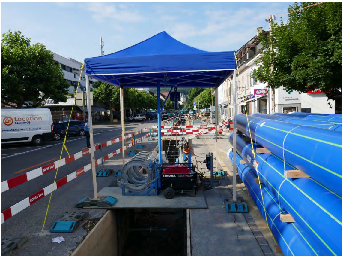
Die Maschinen für die Montage der neuen Transportwasserleitung sind installiert
