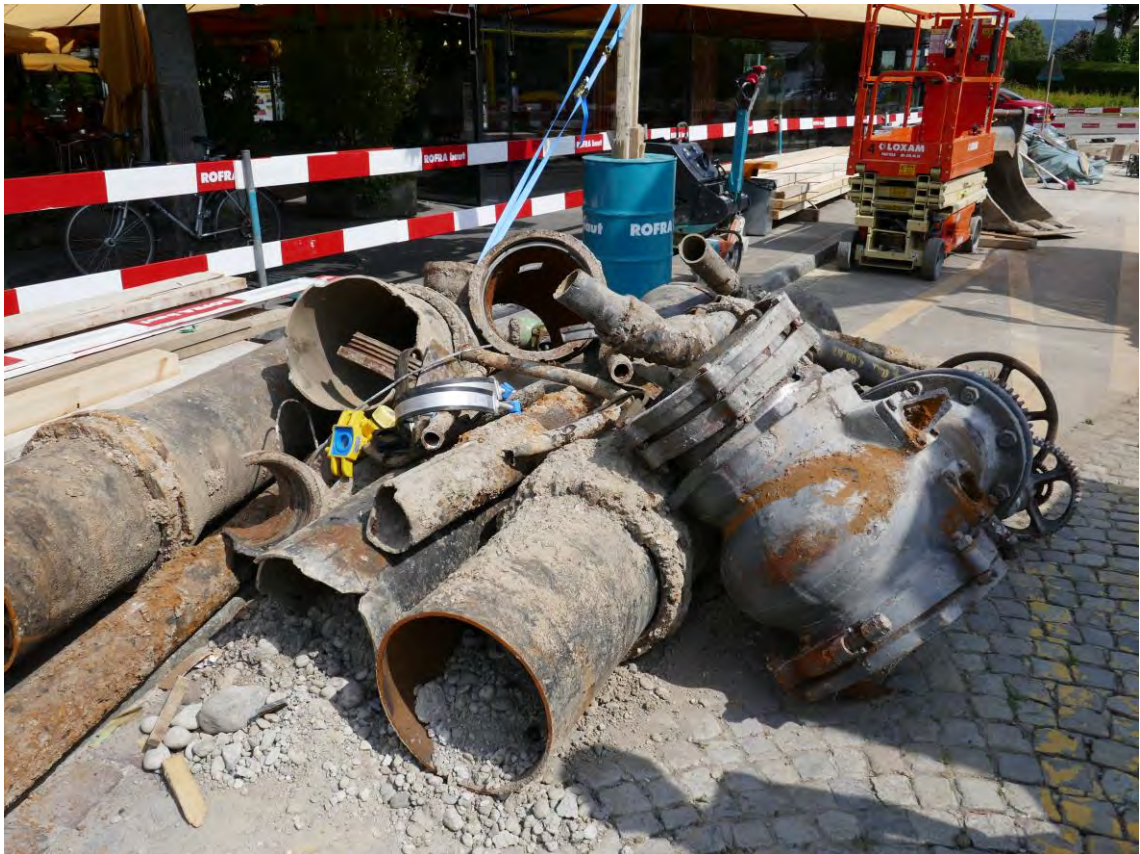
Die alten Gussrohre der Transportwasserleitung sind entfernt
