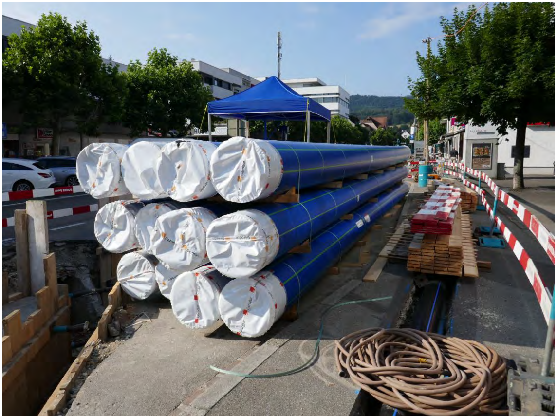
Die neuen Kunststoffrohre für die Transportwasserleitung sind geliefert
