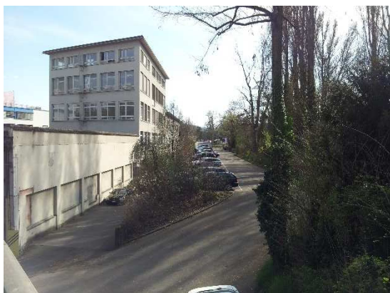
Abb. 7: Rückseite des Kunsthouses Baselland auf der Parzelle Nr. 1501 mit Parkplätzen sowie der Erschliessungsstrasse auf der Parzelle Nr. 999 für das Lager des TBA auf dem westlichen Areal
