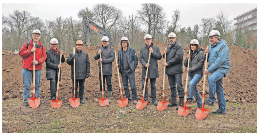
Vertreter der Gemeinde Muttenz und der Bauträger begannen gestern mit dem Spatenstich symbolisch den Bau der Trinkwasseraufbereitungsanlage. MARTIN TÖNGI
